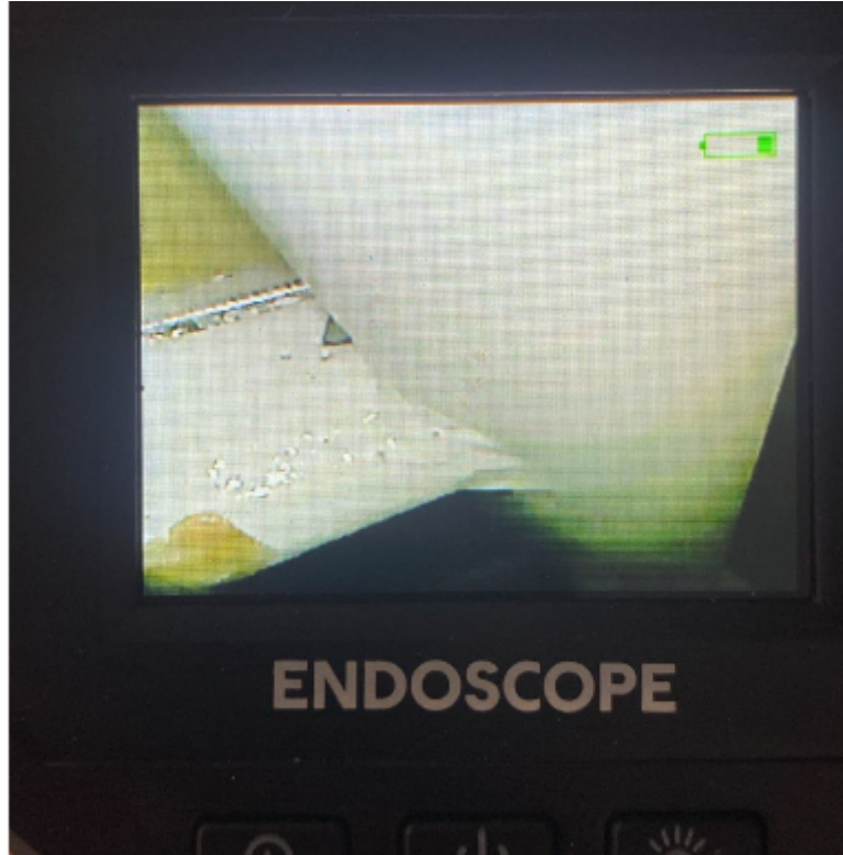
Figura 4: Pontos de inspeção
