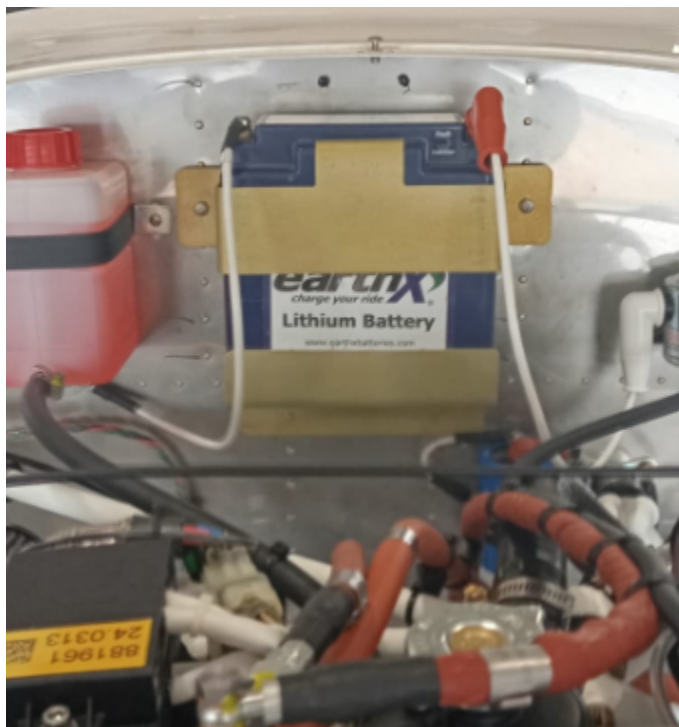
Figura 2.4.13.1. Instalação final da bateria.
